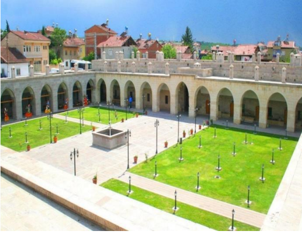
Görsel 7-8: Battalgazi Silahtar Mustafa Paşa Kervansarayı restore çalışmaları
