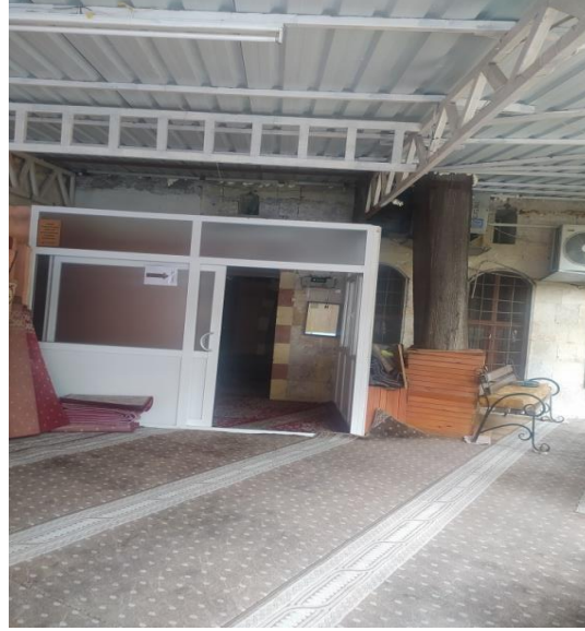
Görsel 8: Harim Giriş Cephesi
