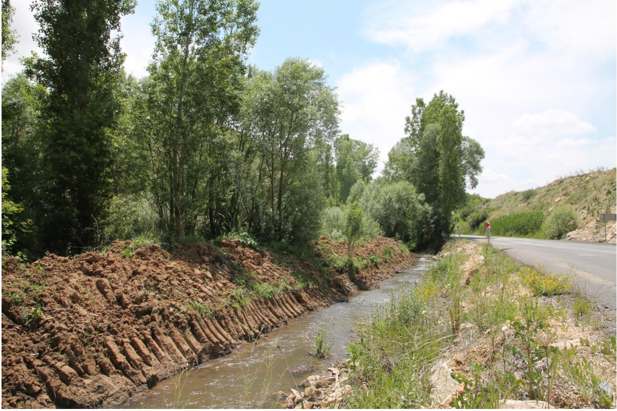
Şekil 3. Açık sistem sulamada uygulanan en kötü teknik araziye doğrudan su salınan yöntem.
