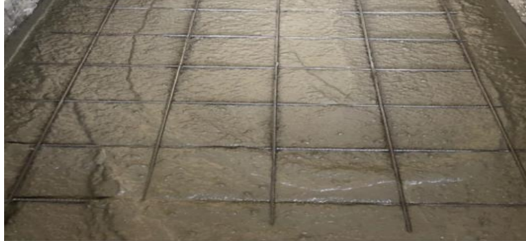
Görsel 4. Q131 Hasır Çeliğin Beton İçine Yerleştirilmesi
