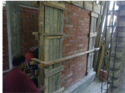
(d) Side Formwork and Concrete Casting
